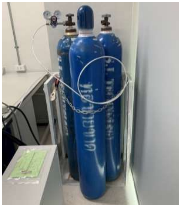
รูปที่ 4.9 การเก็บถังแก๊สโดยมีโซ่ยึดติดกับผนังห้อง
